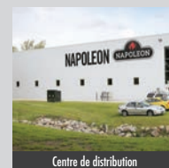
Centre de distribution
